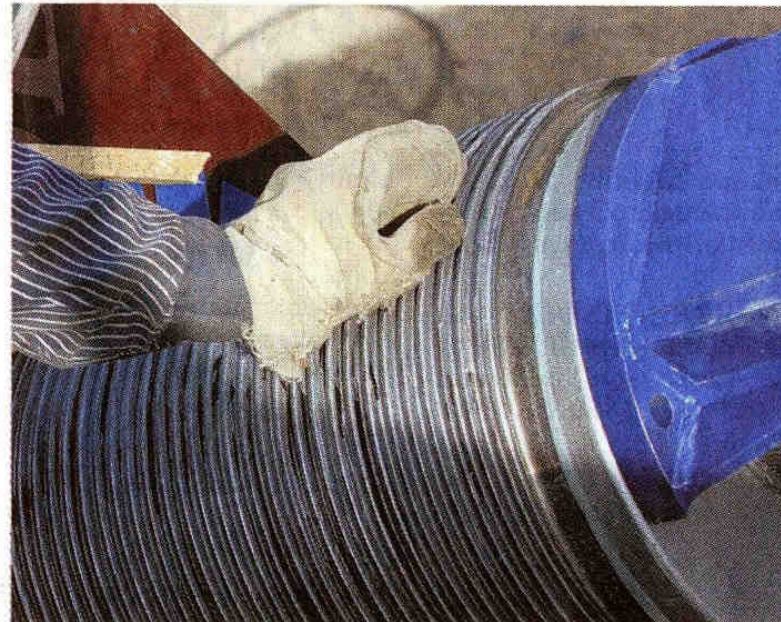
Das Gewinde: Ein Arbeiter legt seine Hand auf die Verankerung eines 15 Zentimeter dicken Stahlseils. Darauf wird eine Mutter geschraubt.
