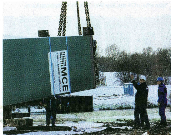
Zusammenarbeit: Johann Brugstaller (2. v. r.) gibt dem Kranfahrer ein Zeichen. Er zieht die Pylone hoch.
