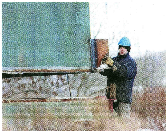
Größenunterschied: Millimetergenau justiert der Arbeiter die riesige Stahlpylone auf ihr passgenaues Unterteil.
