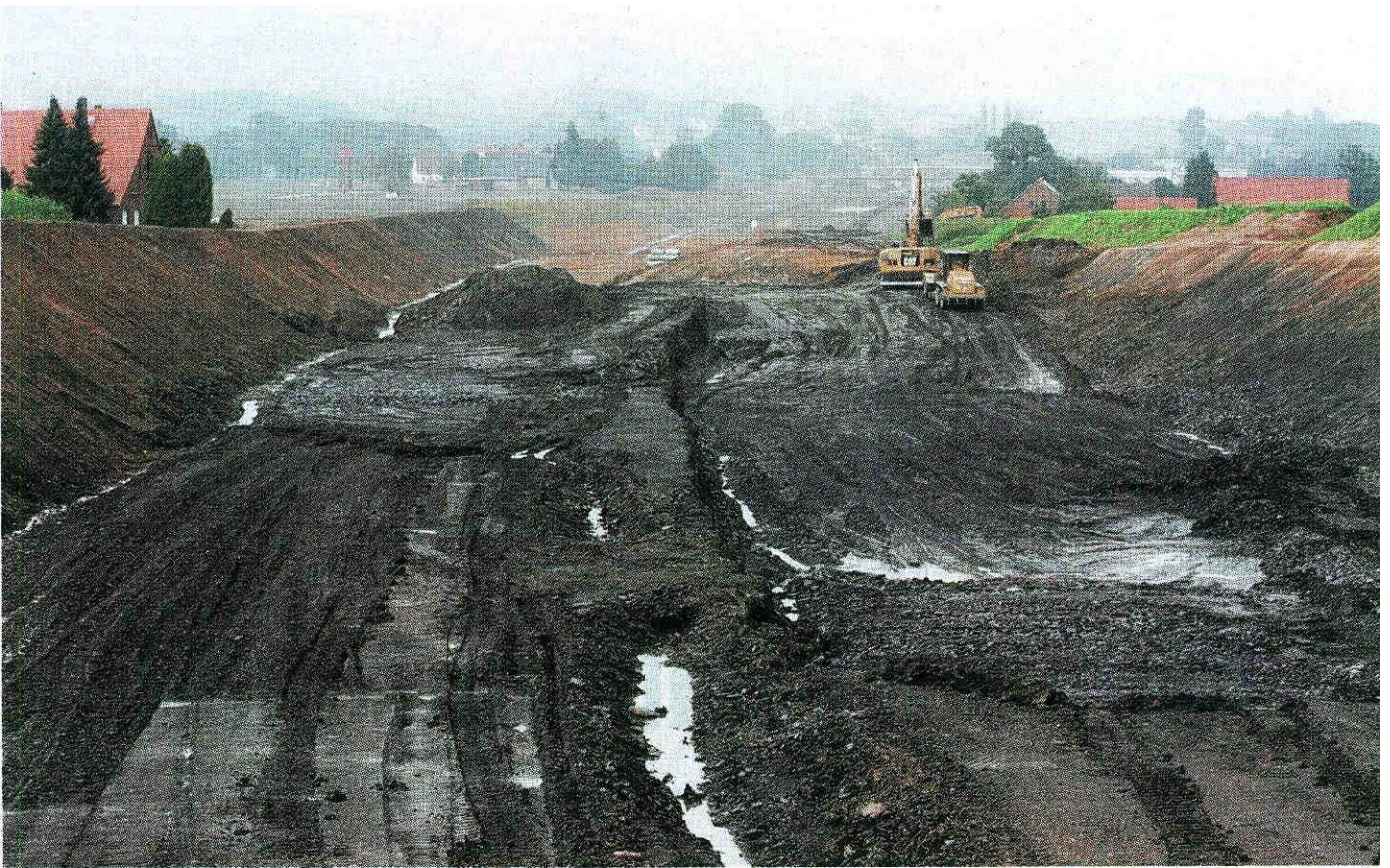
Matschig: Viele Wasserlöcher sind die Erinnerung an den Starkregen im August. Sie erschweren die Arbeiten auf der Nordumgehungs-Trasse. Hinter dem Bagger ist die Brücke Eidinghausener Straße zu sehen, rechts hinter dem grünen Teil des Walls biegt die Stüher Straße ab.
