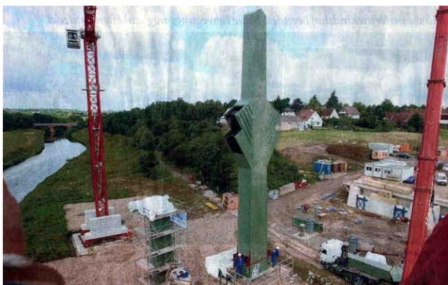
Die erste Pylone steht: Fünf weitere werden für die Werre-Brücke der Nordumgehung noch hinzukommen. Unser Foto zeigt den Blick aus dem Korb eines Krans (im Hintergrund) mit der Werre am linken Bildrand. Rechts unten fährt gerade der Tieflader mit der zweiten Pylone vor.
