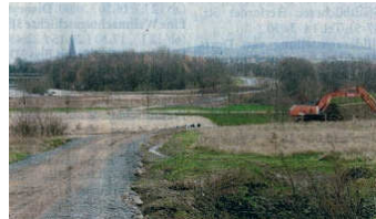
Vorbereitet: Auf beiden Seiten der Werre haben die Bauarbeiten für die A30 begonnen. Hinten ist der Rehmer Kirchturm zu sehen.
