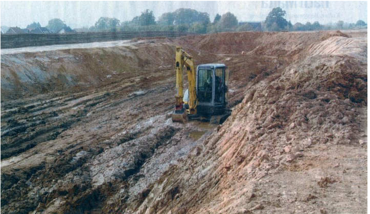
Tiefer Einschnitt: Auf knapp vier Metern sind hinter dem Berufsbildungswerk an der Nordstraße die ersten 100 Meter der Trasse ausgebaggert. Mit dem kleinen Minibagger wird nun lediglich Feinarbeit gemacht. Am Horizont links sind die ersten Einfamilienhäuser der Schwagerstraße erkennbar.
