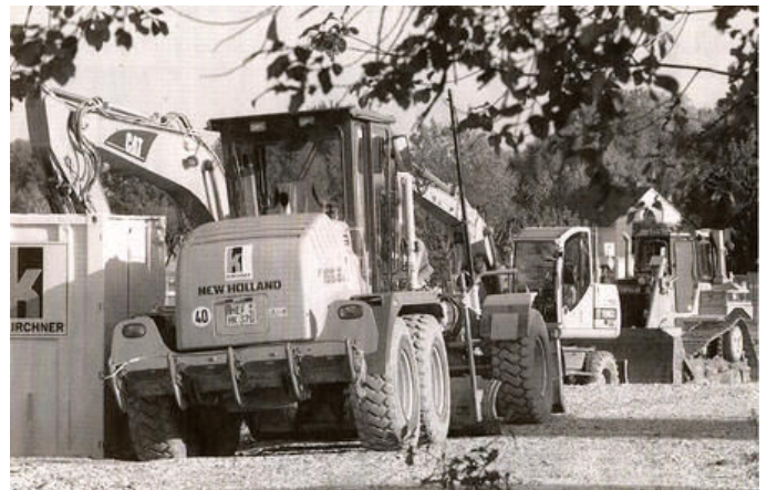
Startklar: Die Flotte der schweren Baufahrzeuge steht in einer Reihe in Nähe des Berufsbildungswerks an der Nordstraße und wartet auf ihren Einsatz. Für Bagger und Raupen wurde eigens eine Baustraße aus Schotter angelegt.
