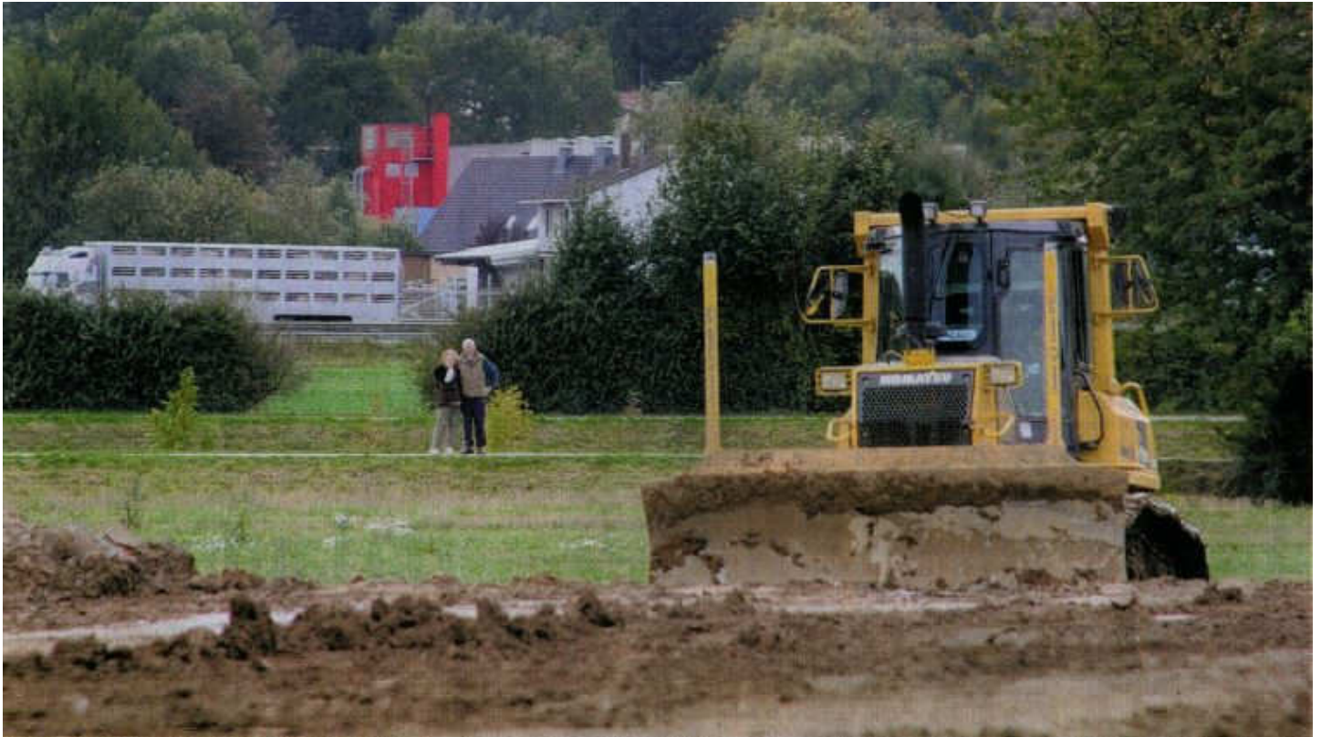
Erdarbeiten: Mit einer Raupe wird der Boden für die Autobahnbrücke aufgeschichtet. Im Hintergrund schauen zwei Spaziergänger vom Werredeich zu, dahinter fährt ein Viehtransport über die A30. Ganz hinten ist der rote Turm der Gohfelder Tischlerei Schormann zu erkennen. FOTO:ULF HANKE
