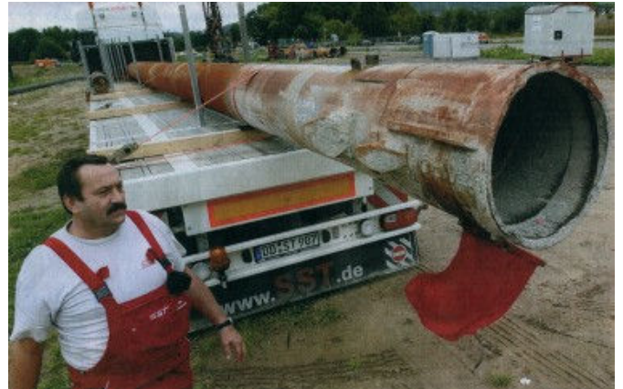
Tiefgründig: Im Bereich der Eidinghausener Straße ist der Dresdner Frank Seifert mit seinem Transporter vorgefahren. Seine Fracht sind ein 16 Meter langes Ramm-Rohr sowie ein vier Meter langer Rammbock, mit dem die Brückenfundamente in den Boden getrieben werden sollen
