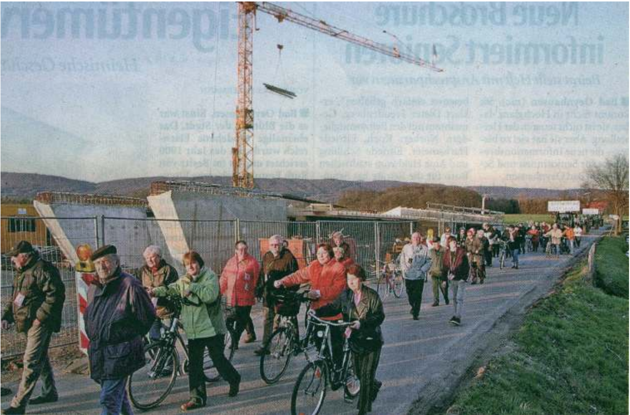
Langer Protestzug: Bei ihrer Jubiläumsdemonstration zogen die Gegner der Nordumgehung vorbei an der Baustelle, kreuzten die Eidinghausener Straße und versammelten sich schließlich auf dem Gelände des Wittekindshofer Berufsbildungswerks.
