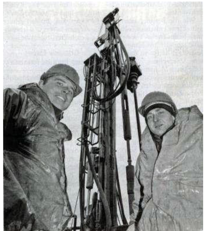
Spezialisten: Carsten Hadel (l.) und Thomas Lange bohren an der Werre bis zu 25 Meter tief.
